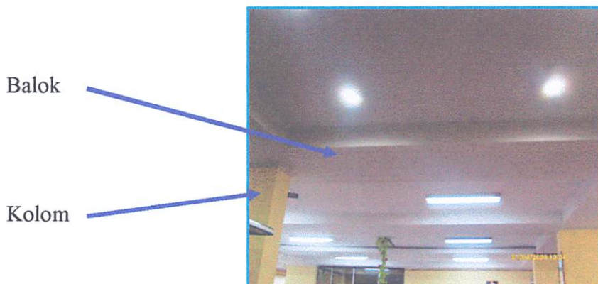
Gambar 3.27 kolom dan balok sebagai struktur bangunan perpustakaan umum kota Malang
