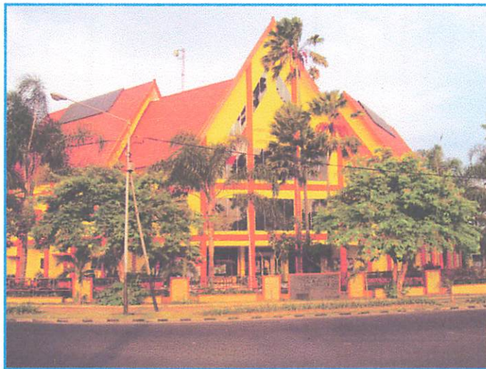
Gambar 3.28 tampak depan perpustakaan umum kota Malang
