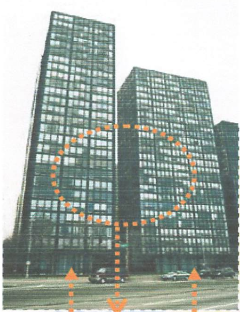
: Apartemen terdiri dari dua menara kembar, berbentuk kotak segi empat panjang. Kedua unit menara lantai dasarnya kosong 'diangkat' oleh kolom, disusun dalam tata letak tegak lurus satu dengan yang lain. Gambar 8.a
