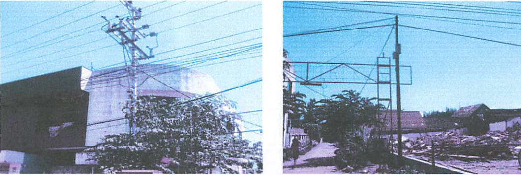
Gambar: jaringan listrik dan telepon
