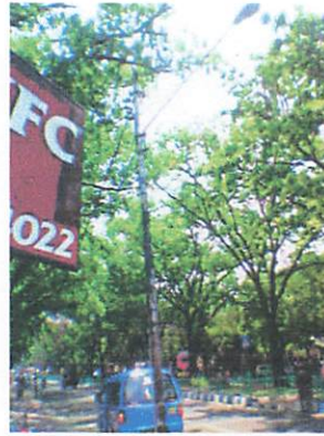
Jaringan Listrik pada site
