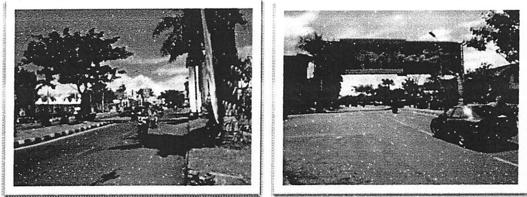
kondisi jalan depan lokasi site
