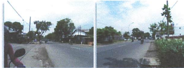
Gambar 4.11 Kondisi Jalan Baik
