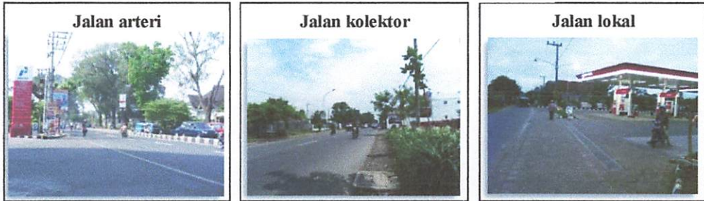
Gambar 4.8 Kondisi Fungsi Jalan Pendukung
