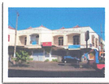
Gbr.29. penyediaan listrik dan telepon Jl. Panji Suroso (sumber: hasil survei 2009)
