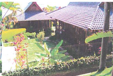
Superior double room : dinding dari kulit kayu yang ditata.
