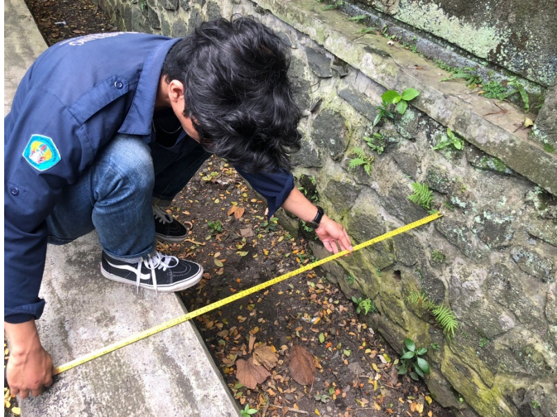
Gambar Pengukuran Dimensi Saluran Drainase Eksisting
