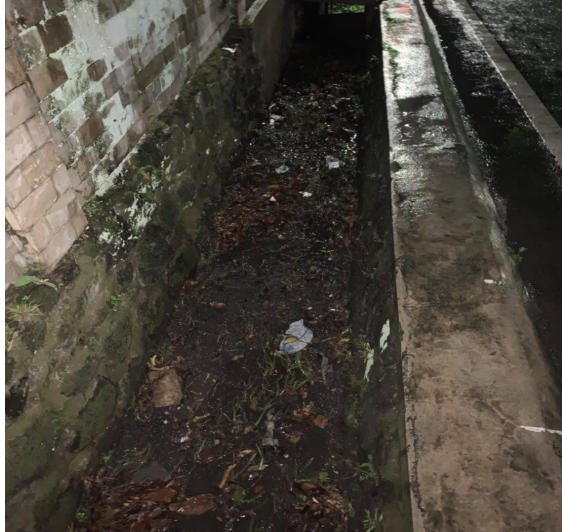
Gambar Kondisi Saluran Eksisting
