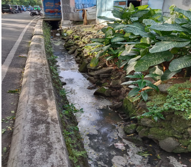
Gambar Kondisi Saluran Eksisting
