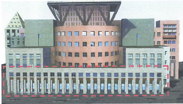
Gambar III.11: Bagian depan gedung dengan kolom-kolom vertikal dan penegasan warna.
