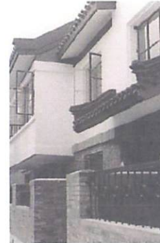
Gambar 2.10.. Tampak bangunan Beijing Ju'er Hutong. Ada penambahan lantai, menjadi 2 lantai akibat penyesuaian dengan jumlah penduduk (Beng, 1998)
