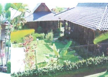
Superior double room : dinding dari kulit kayu yang ditata.
