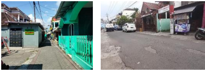
Gambar 4. 5 Kondisi Jalan di Kampung Tempe Sanan
