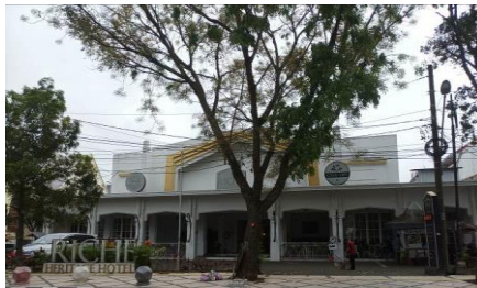
Gambar 1. 6 Bangunan Hotel Riche Kota Malang Sumber: Dokumentasi 2022
