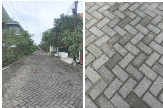
Gambar 10 Perkerasan jalan Paving Blok
