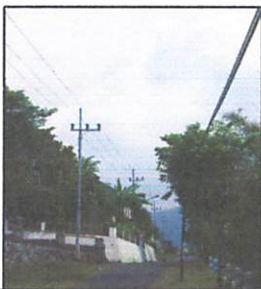
Saluran Listrik masuk pada lokasi ini, dengan Jarak antar tiang listrik sekitar 25-30 meter
