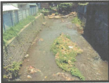
Gambar 4.1 Kondisi Sungai Kasin
