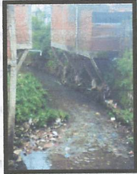
Gambar 4.2 Kondisi Sungai Kasin
