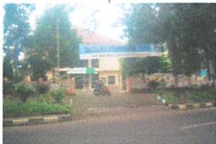
Kantor Camat Kedungkandang
