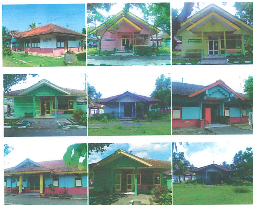
Gambar 27 Wisma Penyandang Tunanetra
