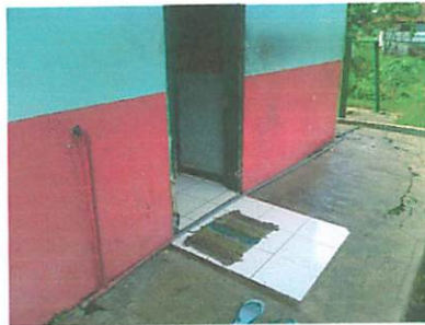
Gambar 30 Lantai pada Dinding Wisma Tunanetra
