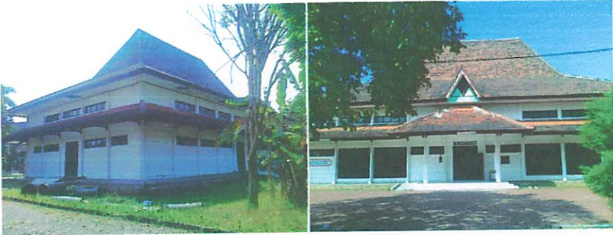
Gambar 49 Gedung Serba Guna
