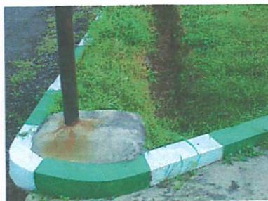
Gambar 36 Drainasi tidak tertutup
