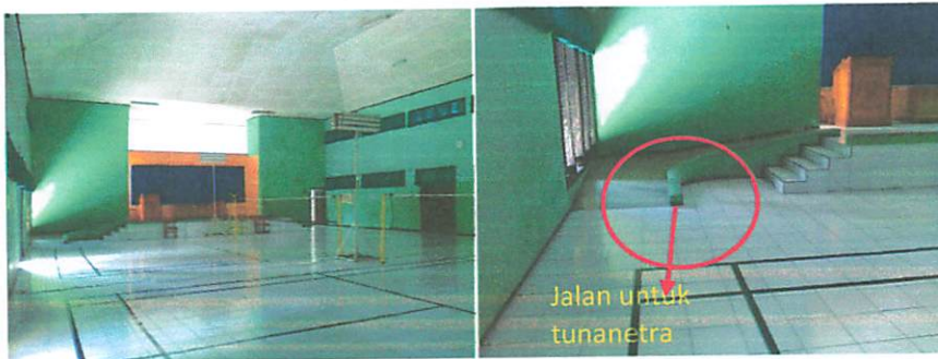
Gambar 50 Kondisi dalam Gedung Serba Guna
