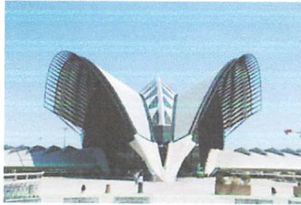
Gambar 2.18: Stasiun TGV, Calatrava
