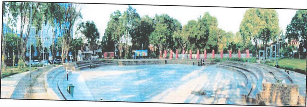
Gambar 2.34 Fasilitas penunjang amphitheater
