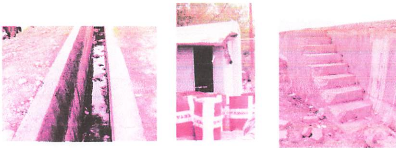
Pembuangan air, genset dan tangga menuju perbatasan darat dan laut
