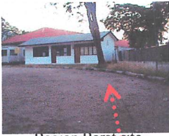
Bagian Barat site
