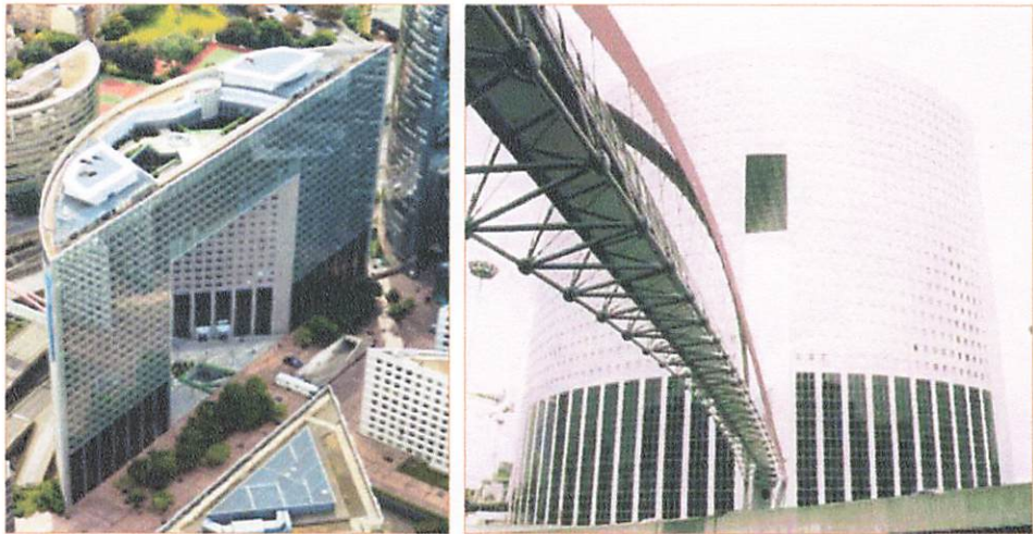
Gambar 2.4. taman diatas atap dan jembatan arch
