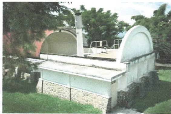
Gambar III.3.22. Atap Gedung Bamberg dapat digeser maju mundur
