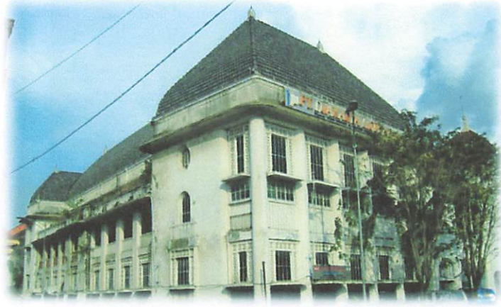
Gambar 2.7. Gedung Jakarta Lloyd Jl. Mpu Tantular Semarang
