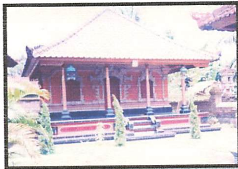
Gambar 6.15 Bangunan tradisional Bali
