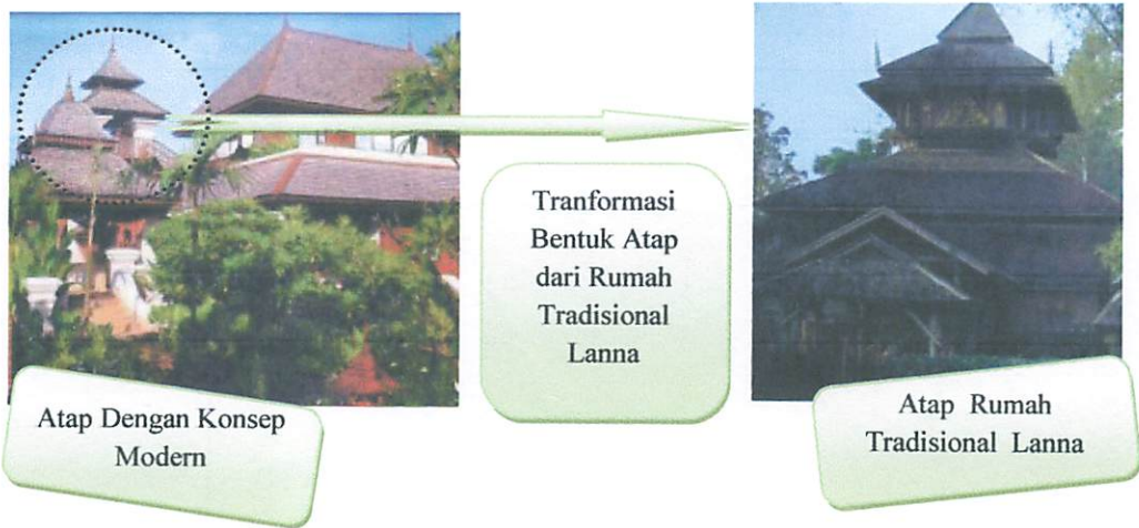
Gambar 2.4 Atap yang bertumpuk juga ditemui pada bangunan Regent Residence (Beng, 1996) 3
