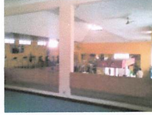
Gambar 4.25 Ruang cardiovascular dan ruang body pump serta receptionist, terlihat pada lantai 2 ruang senam. Pada ruang fitness tidak menggunakan kolom (bebas kolom). Sumber : Doc.Survey.
