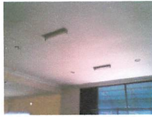
Gambar 4.30 Pencahayaan pada ruang senam menggunakan jenis lampu downlight dan TL panjang. Sumber : Doc.Survey.
