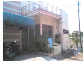
Gambar 4.45 Ruang genset. Ruang ini terletak didepan rg.bodypump. Sumber : Doc.Survey.
