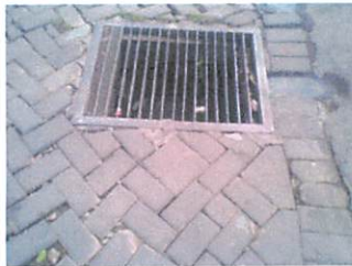
Gambar 3.21. Jalur Riol Kota. (Foto No.1). Sumber : Doc.Survei.
