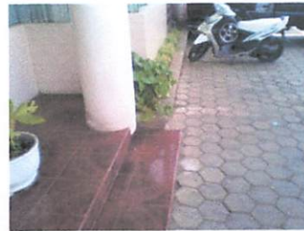
Gambar 4.51 Tempat parkir motor, dengan perkerasan paving. Penataan lansekap pada parkir motor. Sumber : Doc.Survey.
