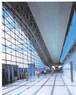
Gambar 6.53 Penggunaan Bahan Kaca sebagai Skylight Pada Samping Bangunan. Sumber : Album Arsitektur Arsindo.
