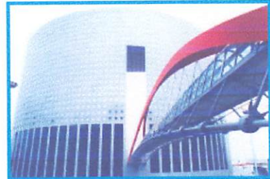
Gambar 21. Jembatan Melengkung / Arch.
