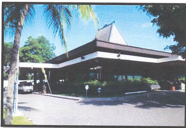
Gambar 2.28 : Gedung Wanitatama Yogyakarta.
