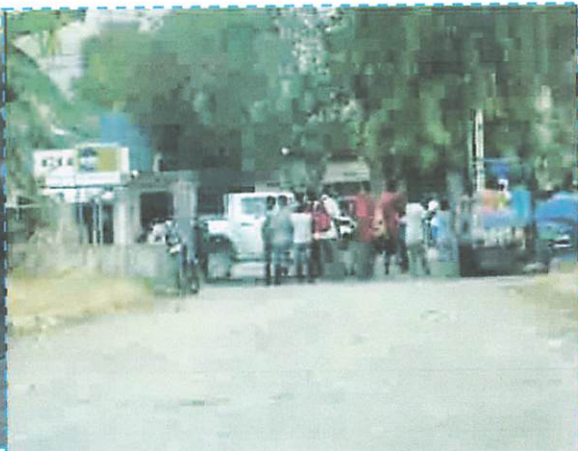
Foto 21. Kondisi jalan pada sisi selatan site
