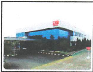
Gambar 3. Pabrik aluminium Krawang Jawa barat
