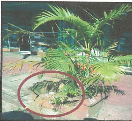
Gambar 1.2 Kondisi pot tanaman peneduh yang rusak pada jalur pedestrian sisi kiri
