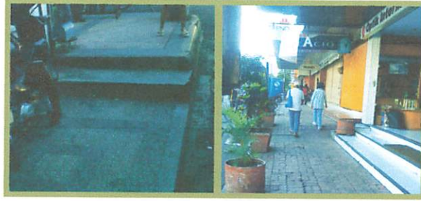
Gambar 4.4. Ramp Pada Jalur Pedestrian
