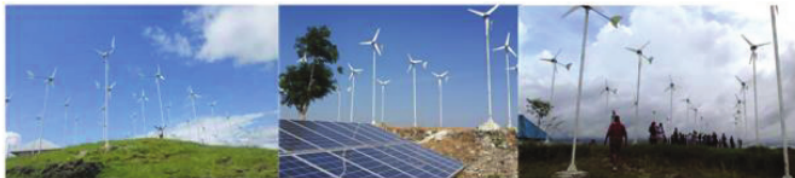
Gambar 3. Potensi Angin dan Surya: Pembangkit Listrik Tenaga Angin dan Surya
