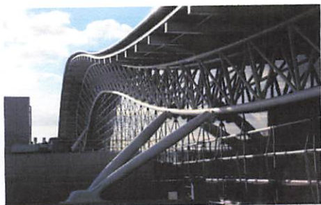
Gambar 2.3.3. Contoh bangunan yang menerapkan metode detailed high tech Osaka International Airport
