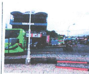
KONDISI BANGUNAN AWAL PADA SITE YANG BERUPA RUMAH MAKAN BERLANTAI 3
