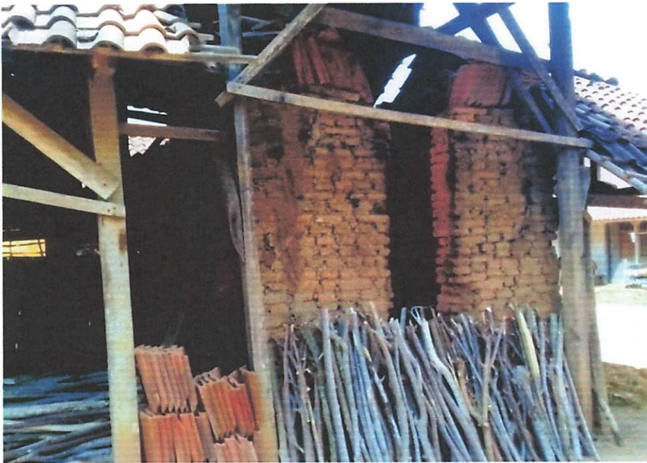
Tempat pembakaran bata merah yang digunakan
