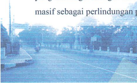
Bukaan penuh terhadap tampilan bangunan dari arah Jl. Kahuripan
