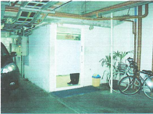
Ruang control yang ada di basement. Semua kegiatan dapat dilihat dari ruang control ini
