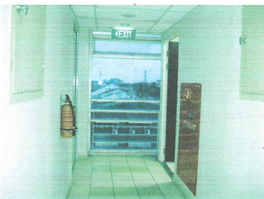
Eksekusi penghuni pada saat terjadinya kebakaran dan tersedianya hydrant box
