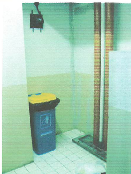
Area Service sebagai tempat pembuangan sampah sementara penghuni yang akan dilakukan pengambilan secara rutin oleh petugas kebersihan.
