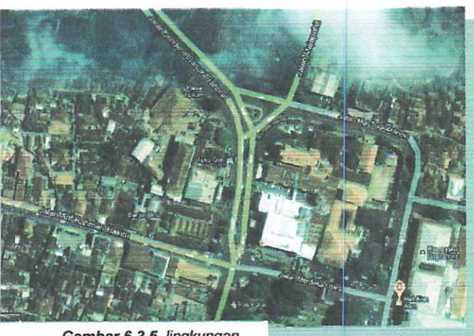
Gambar 6.3.5. lingkungan sekitar site
