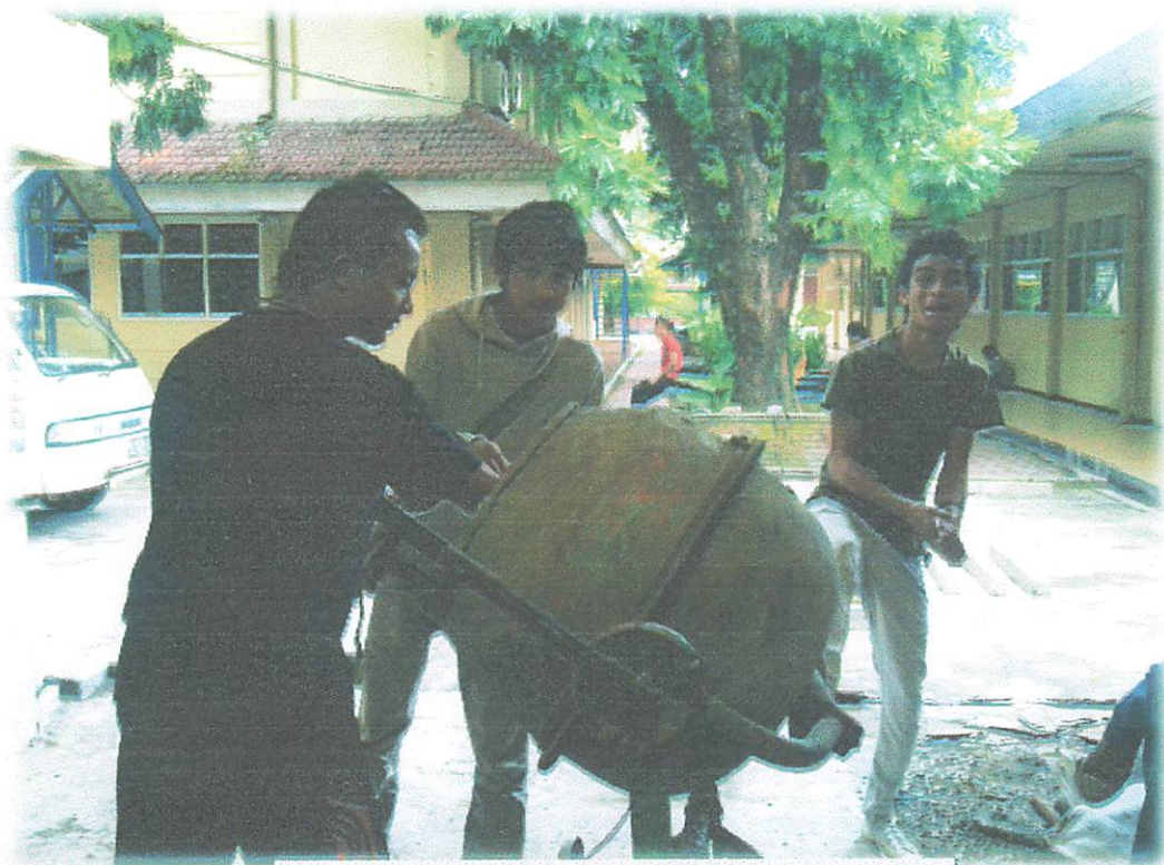
Pencampuran Beton
