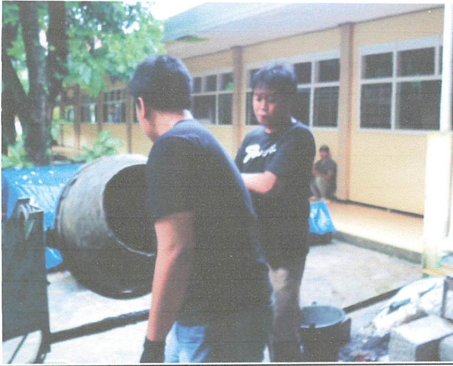
Pencampuran Material Beton dengan Campuran Additive
