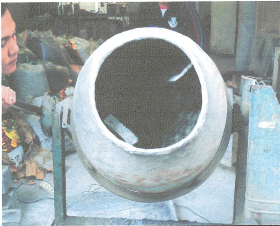
Pencampuran Material Beton Normal
