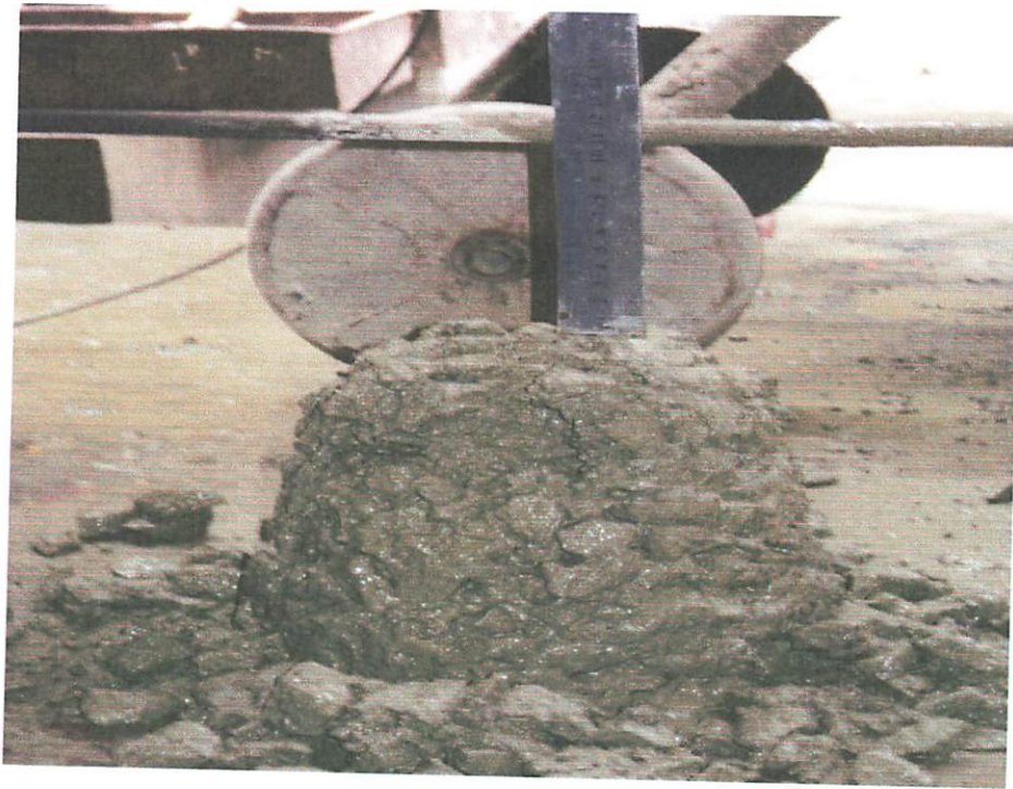
Slump Test Beton dengan Campuran Additive
