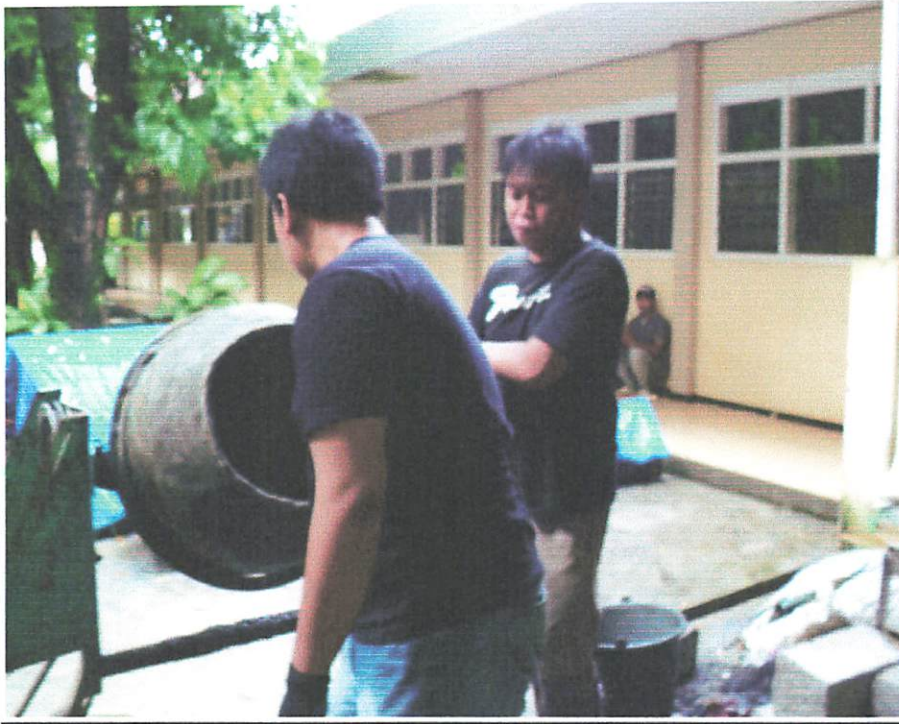
Pencampuran Material Beton dengan Campuran Additive
