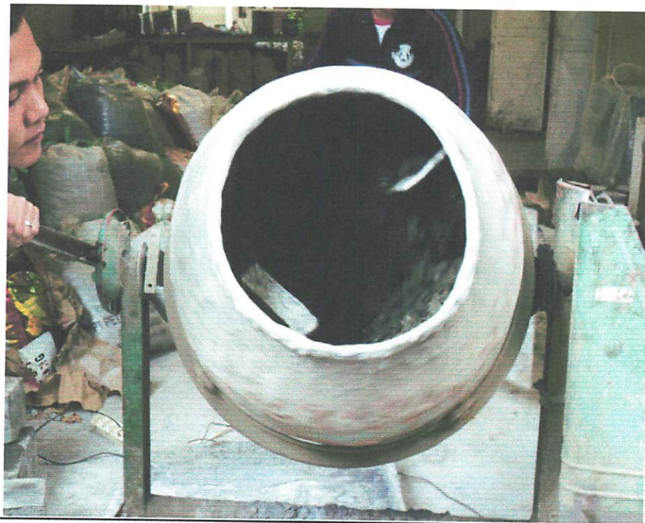
Pencampuran Material Beton Normal
