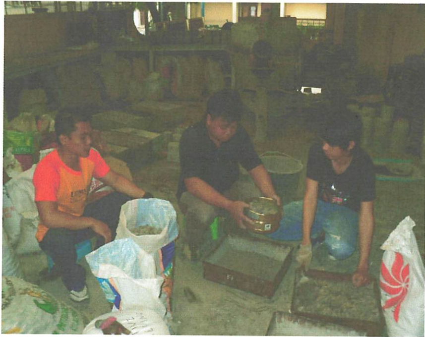
Persiapan Bahan Beton Normal
