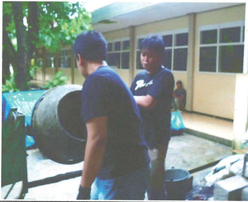
Pencampuran Material Beton dengan Campuran Additive
