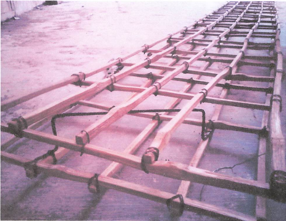
Tulangan Rangkap yang sudah dibentuk
