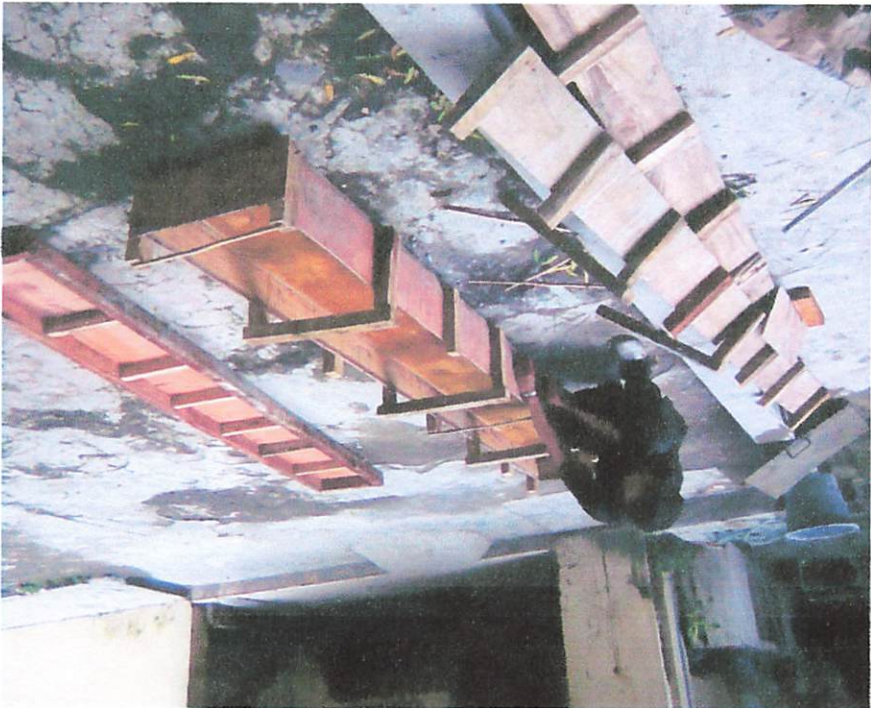
Pembuatan Bekisting
