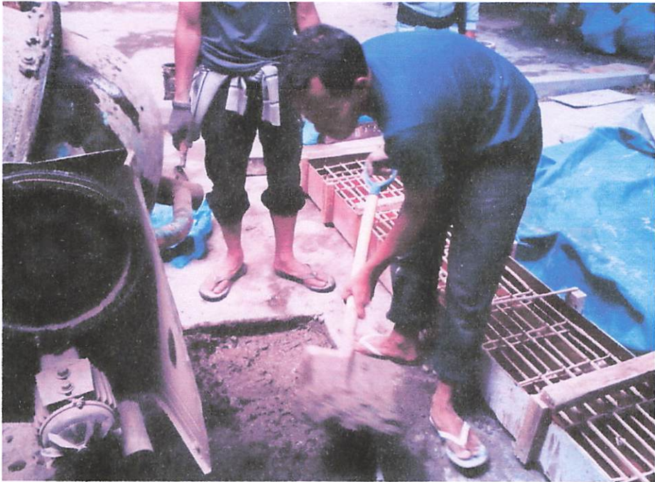
Campuran beton dikeluarkan dari molen
