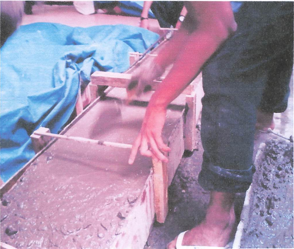
Proses pengecoran Plat
