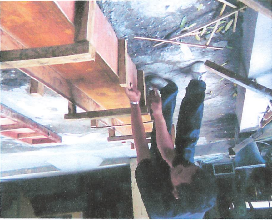
Pembuatan Bekisting
