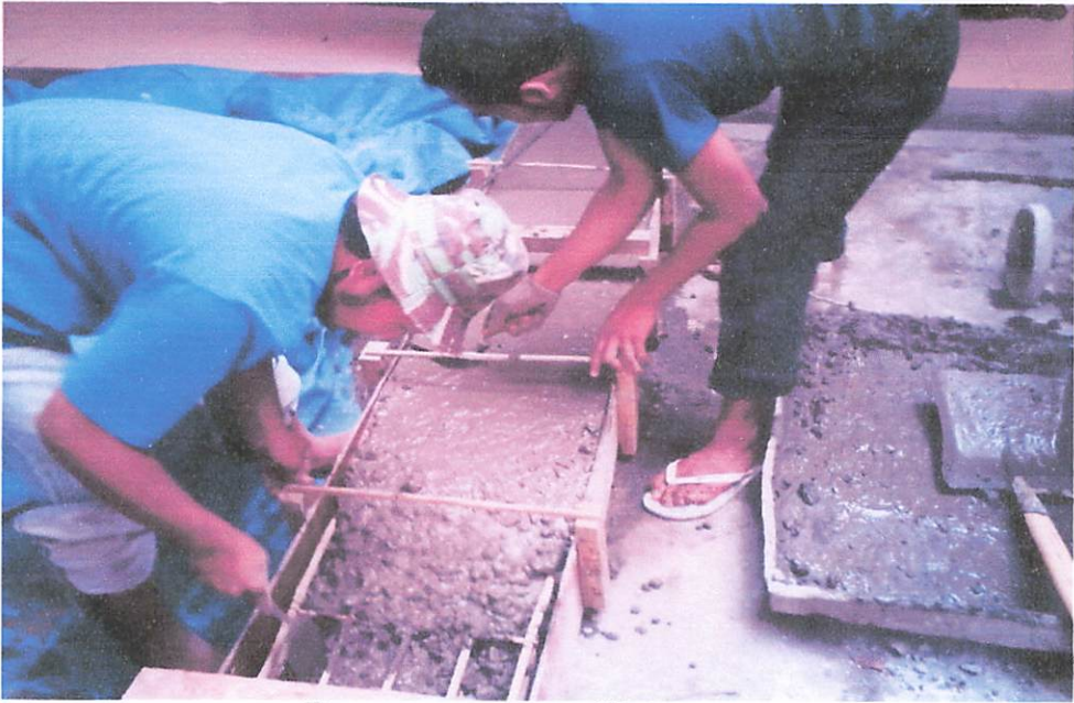
Proses pengecoran Plat
