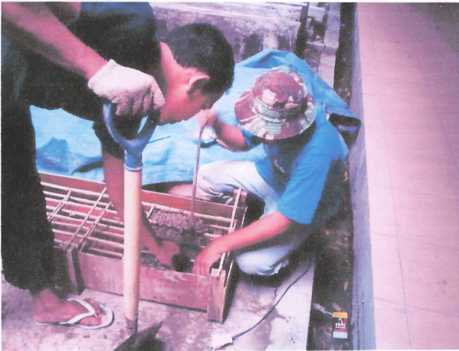
Campuran Beton dimasukkan ke dalam cetakan
