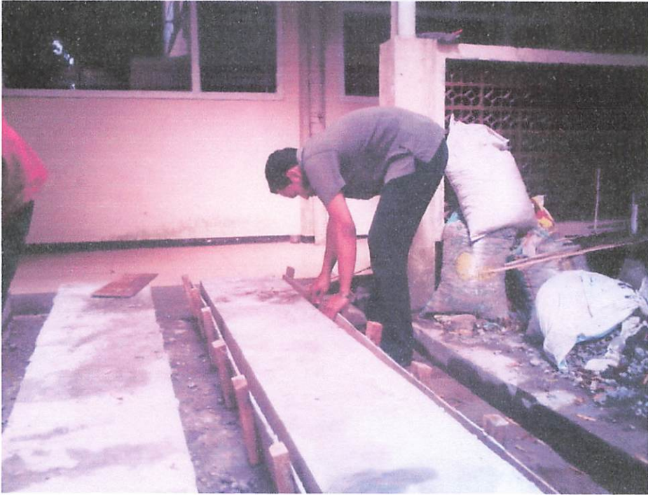
Pelepasan Bekisting
