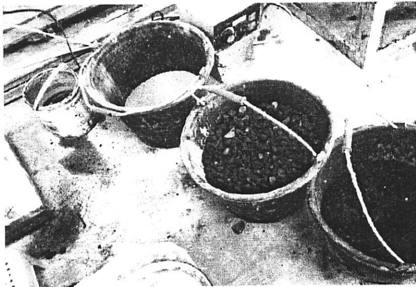
Persiapan Bahan-bahan Pembuatan Beton
