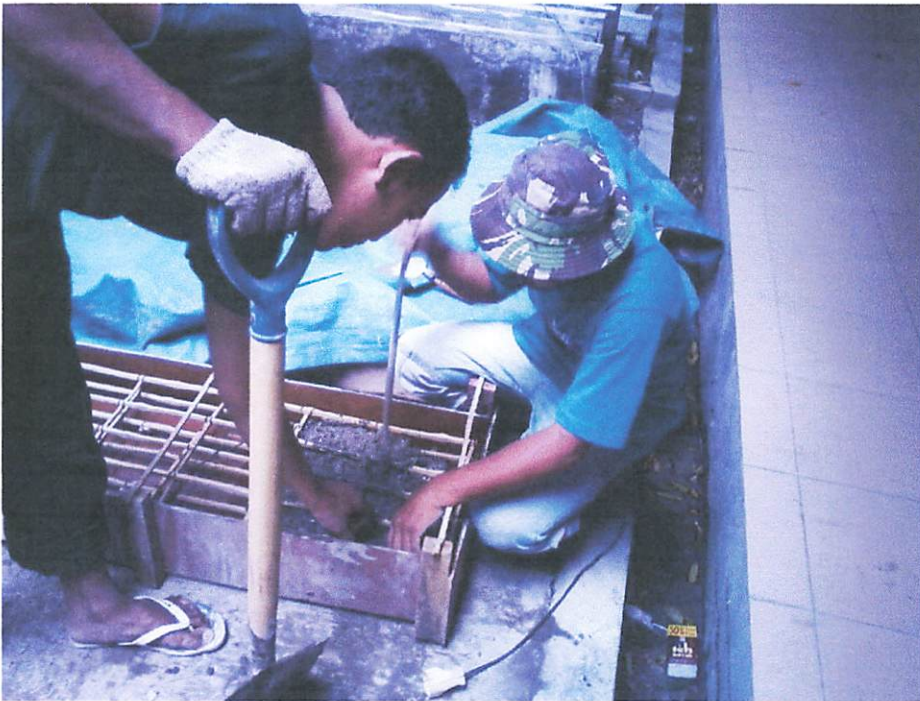
Campuran Beton dimasukkan ke dalam cetakan
