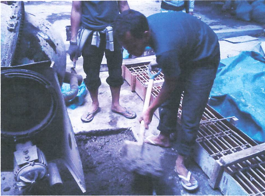
Campuran beton dikeluarkan dari molen
