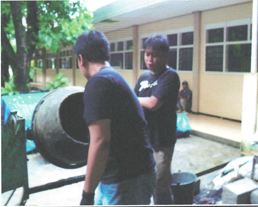
Pencampuran Material Beton dengan Campuran Additive
