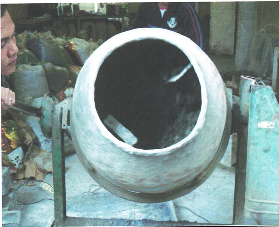
Pencampuran Material Beton Normal
