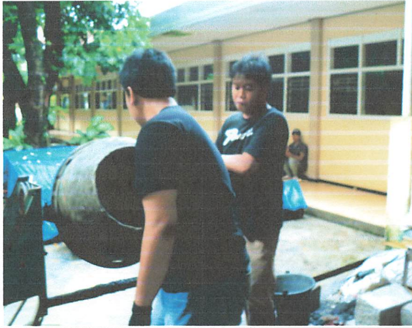
Pencampuran Material Beton dengan Campuran Additive
