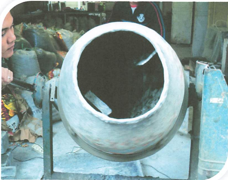
Pencampuran Material Beton Normal
