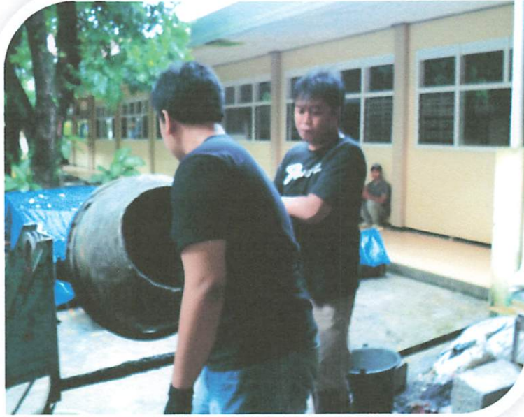
Pencampuran Material Beton dengan Campuran Additive
