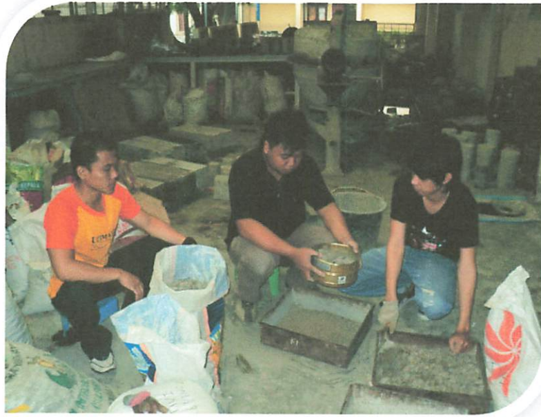
Persiapan Bahan Beton Normal
