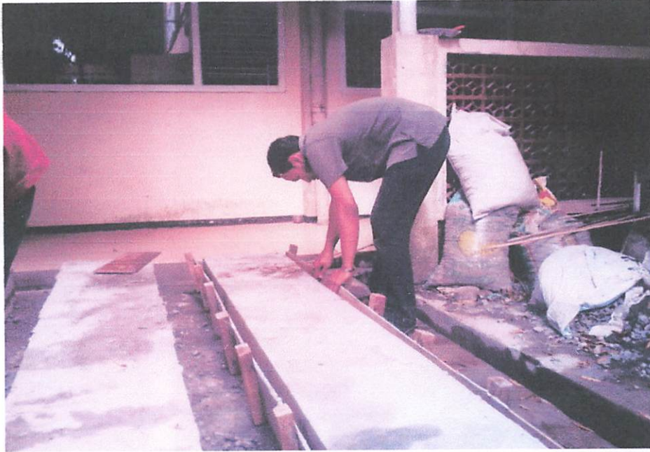
Pelepasan Bekisting
