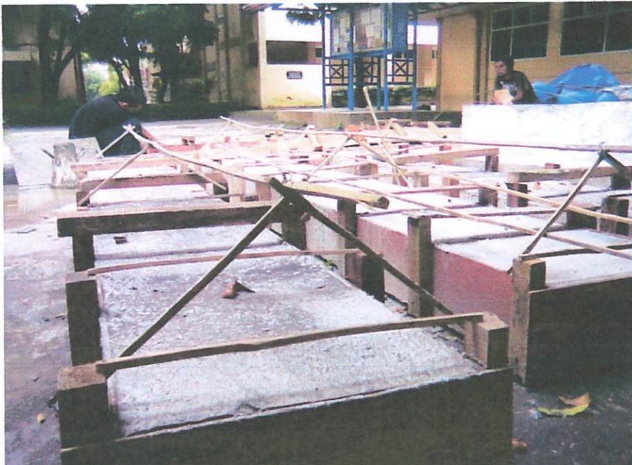
Plat sebelum bekistingnya dilepas
