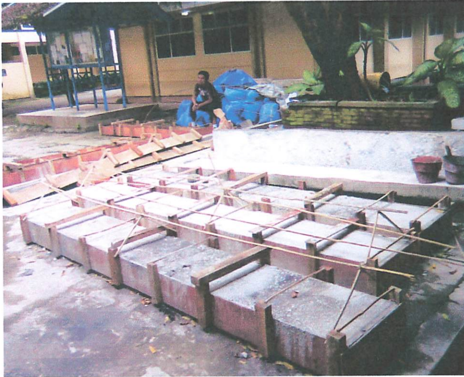
Plat sebelum bekistingnya dilepas
