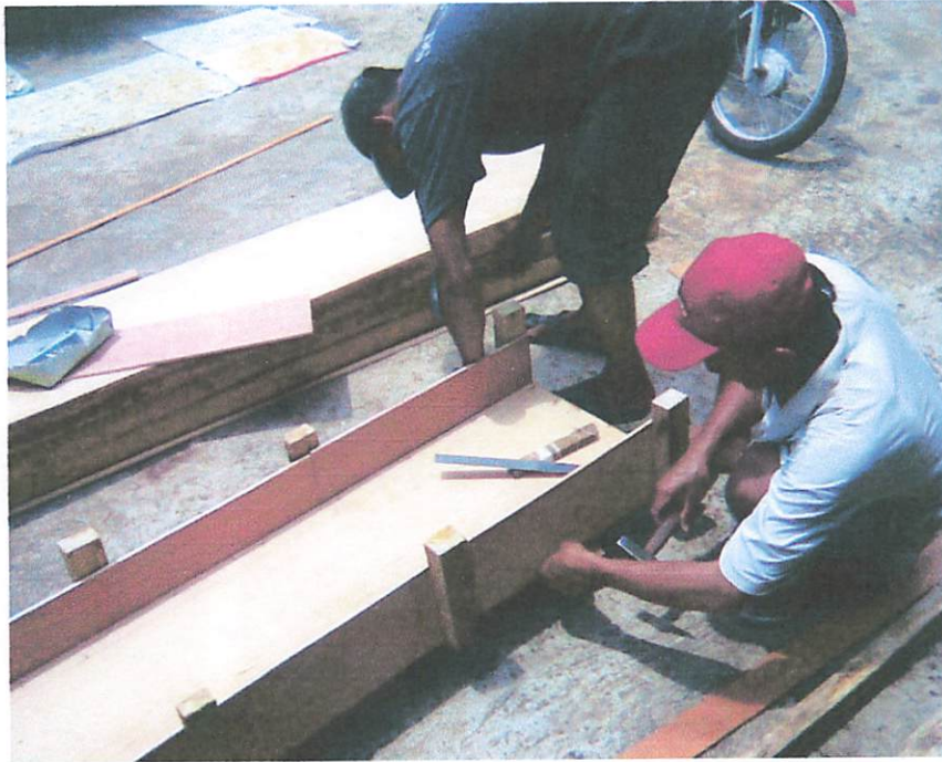
Pembuatan Bekisting
