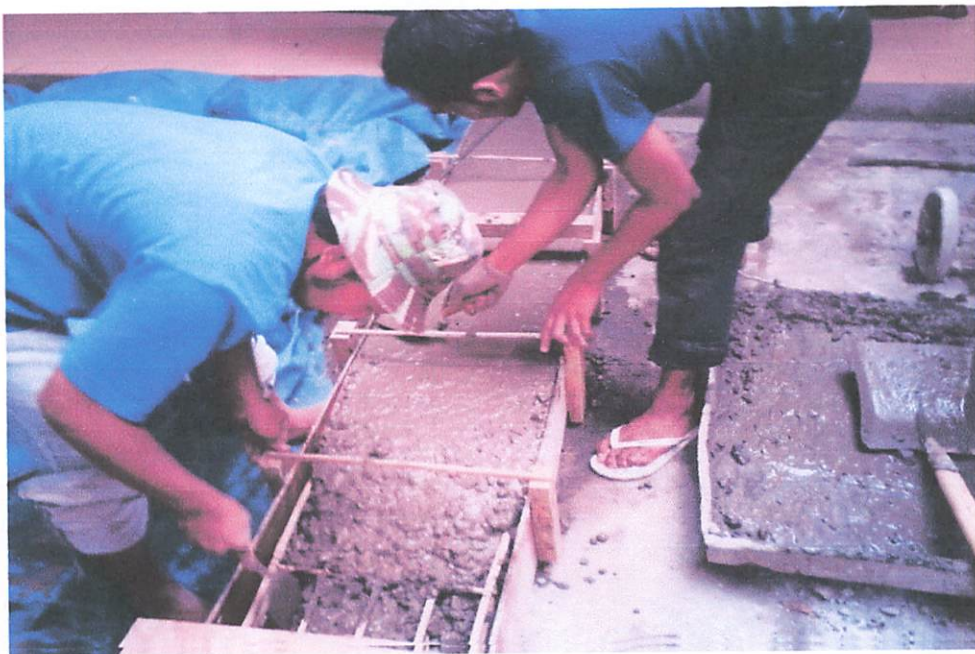
Campuran Beton dimasukkan ke dalam cetakan
