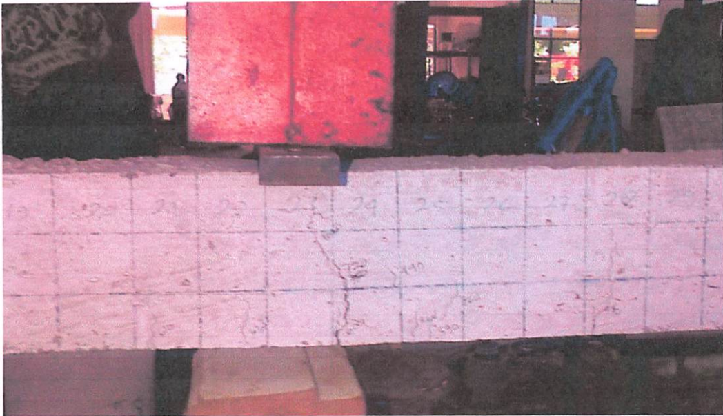
Gambar 4.7 Pola retak balok tanpa sambungan (BTS)-B
