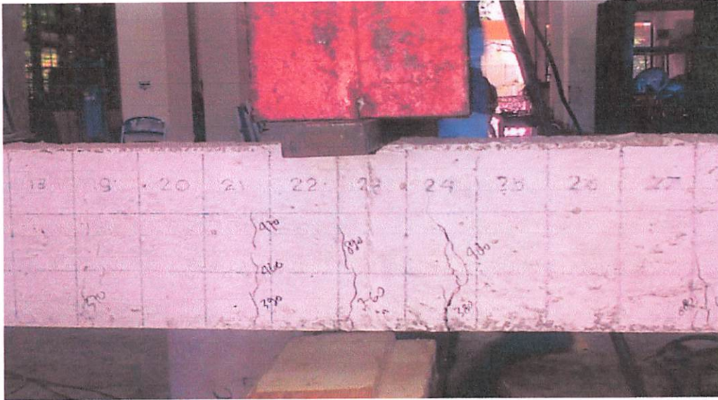
Gambar 4.8 Pola retak balok tanpa sambungan (BTS)-C
